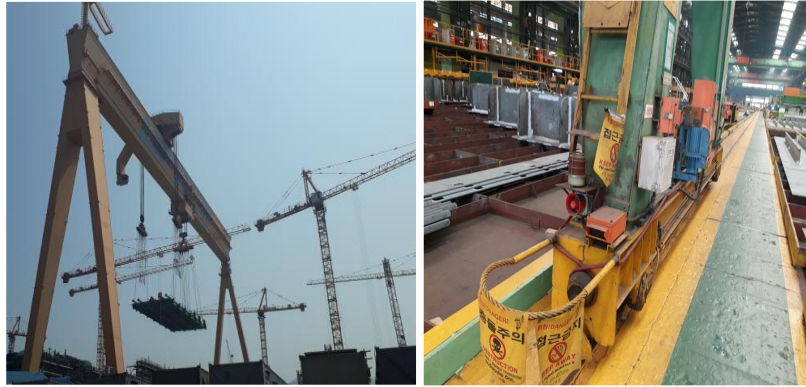
(a) 동일 주행레일이 아닌 크레인 간 충돌위험 (b) 크레인과 사람 간 충돌위험 [Figure 30] 크레인 충돌위험
