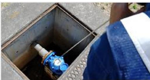
(a) 청음봉을 이용한 방법
