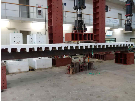
(a) 실험체 설치
