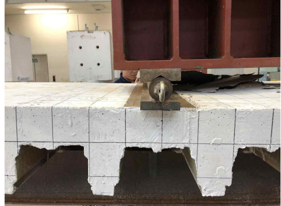
(b) 좌측 가력점 슬래브 정면 균열
