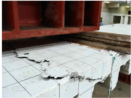
(b) 우측 가력점 슬래브 정면 균열
