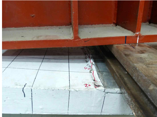
(b) 좌측 가력점 슬래브 정면 균열
