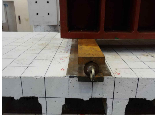
(b) 좌측 가력점 슬래브 정면 균열
