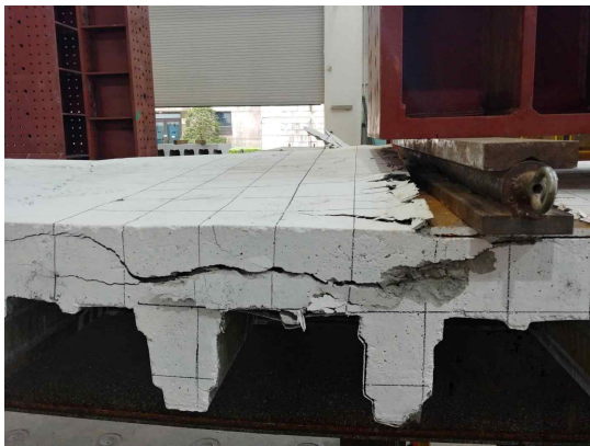
(e) 우측 가력점 슬래브 후면 균열
