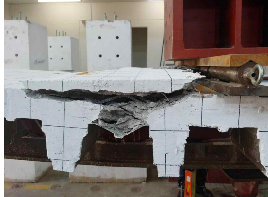
(b) 좌측 가력점 슬래브 정면 균열
