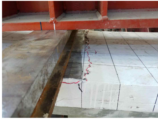
(b) 좌측 가력점 슬래브 정면 균열
