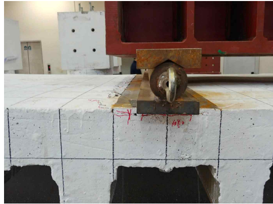
(b) 좌측 가력점 슬래브 정면 균열
