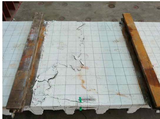
(d) 중앙부 콘크리트 슬래브 균열
