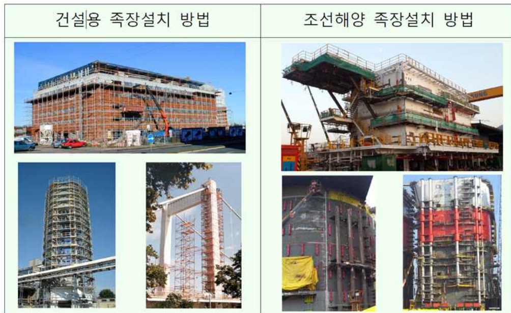
<그림 2-17 > 건설용 비계와 조선해양의 비계설치 방법의 차이
