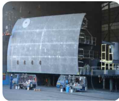
<그림 2-3> 공장내 전처리 및 도장작업
