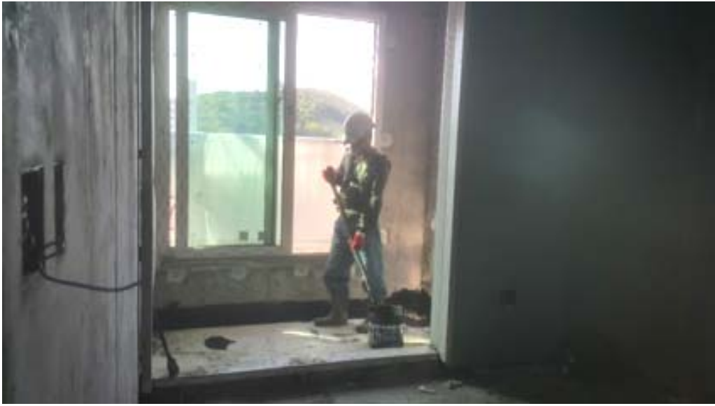
<그림 4> Urethane Waterproof Work Of C Construction Site
