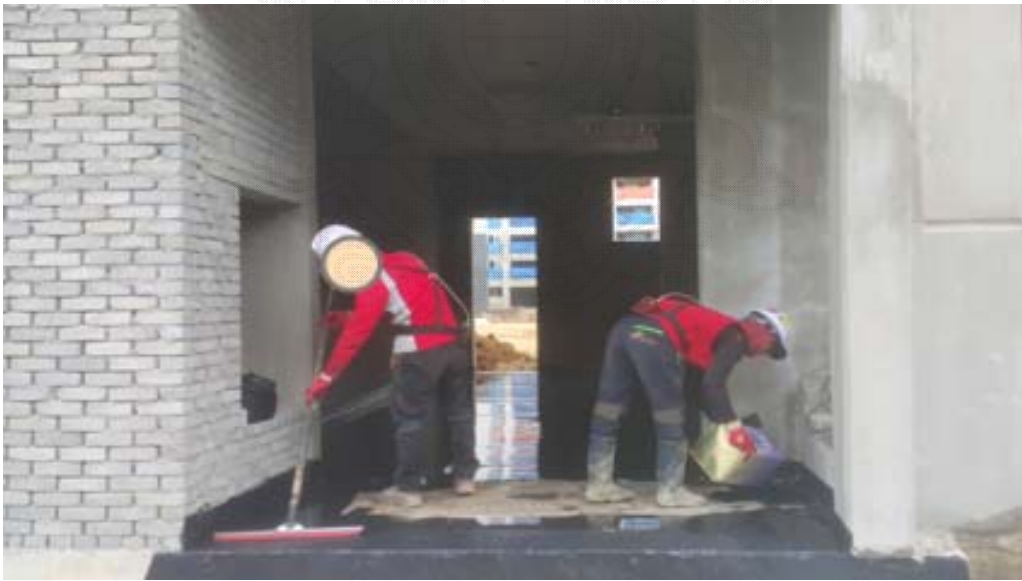
<그림 5> Mixing Process Of D Construction Site
