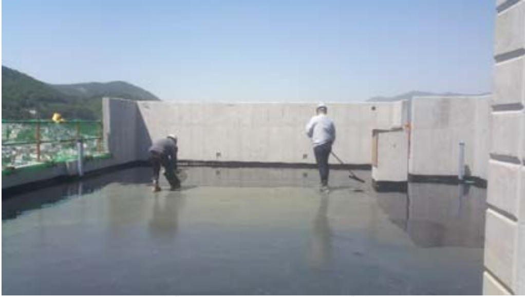
<그림 2> Urethane Waterproof Work Of A Construction Site
