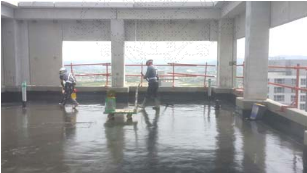
<그림 3> Urethane Waterproof Work Of B Construction Site
