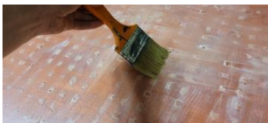
<그림39> 작업 광경(접착제 도포)
